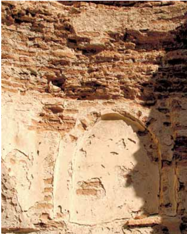
80 a- Ilıklık, Kubbeye Geçiş Sistemi, Ayrıntı
