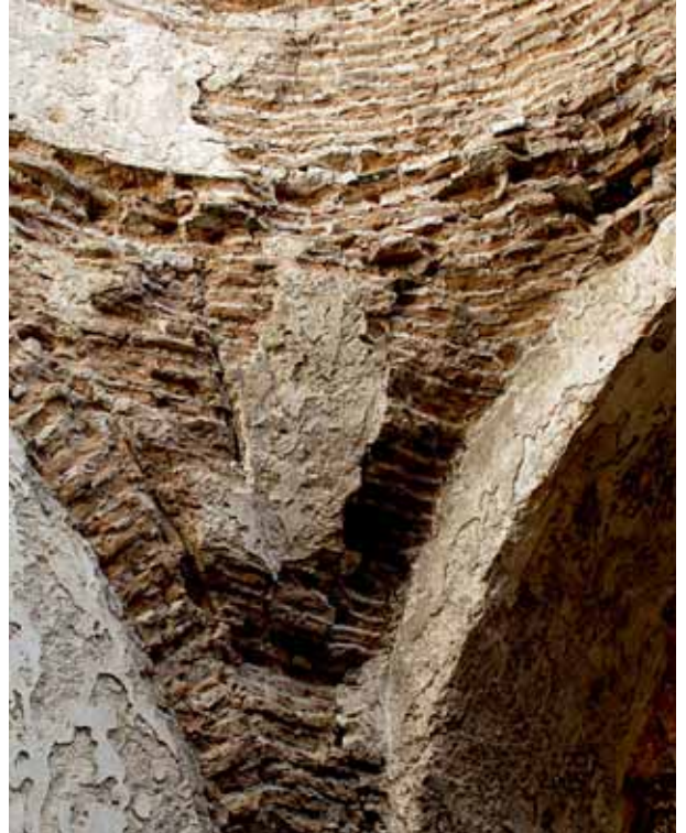
83- Sıcaklık, Kubbeye Geçiş Sistemi Ayrıntı
