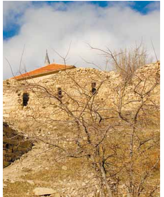
55 b- Güney Cephe
