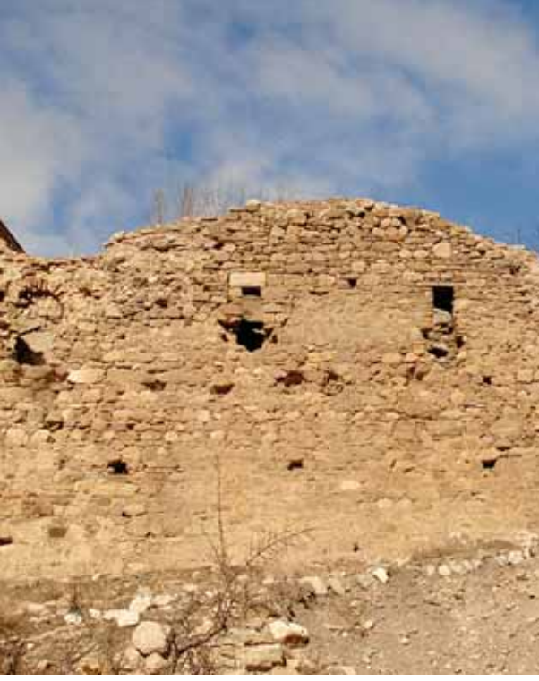
56 a- Güney Cephe
