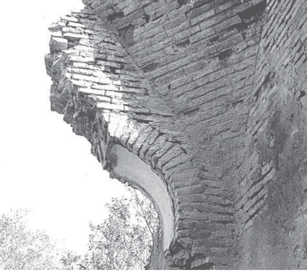
61 a- Avlu, Güneydoğudaki Kemer ve Köşe Üçgeni
