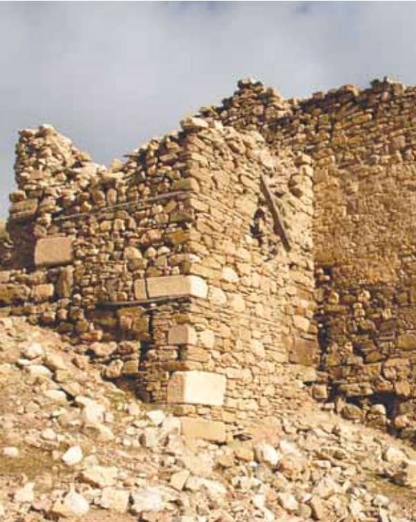
57 a- Batı Cephe, Güney Bölümü
