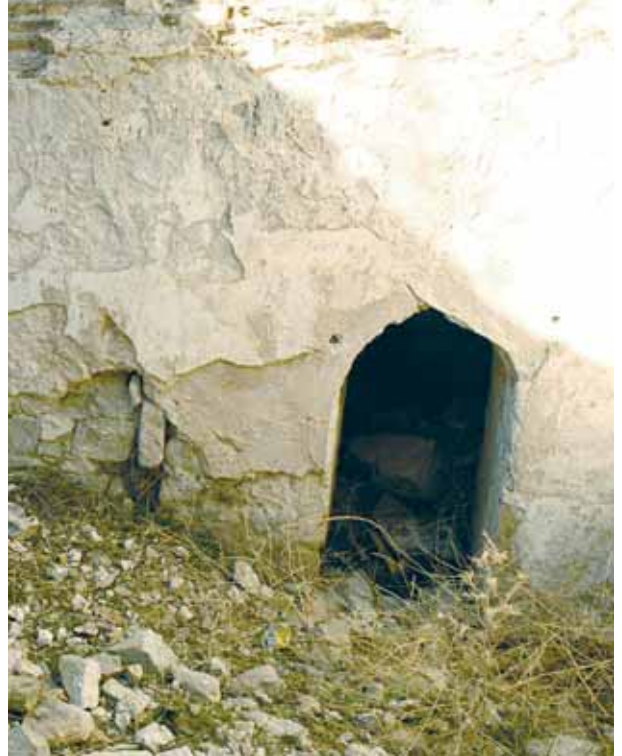
78 b- Ilıklık, Kuzey Duvar
