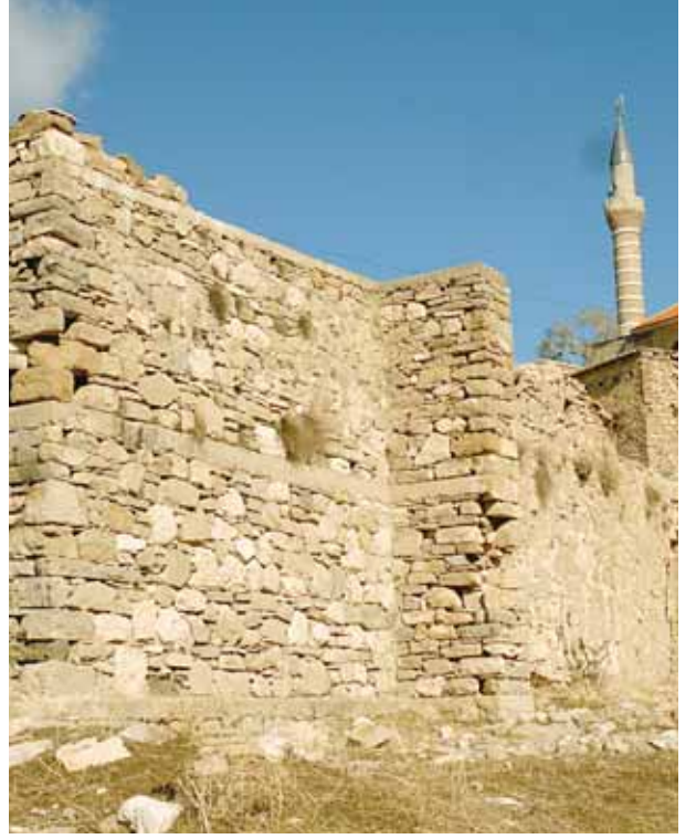
75 b- Güney Cephe
