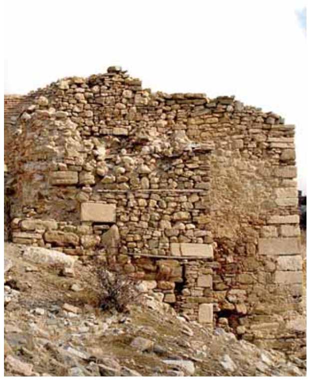
56 b- Batı Cephe
