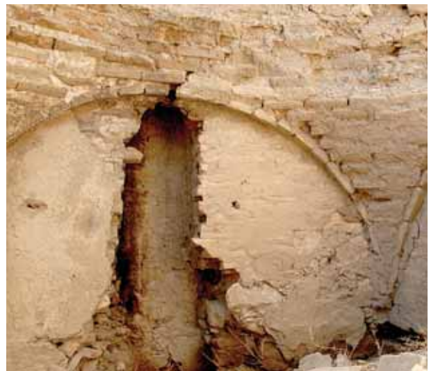
66 Avlu, Ana Eyvanın Güneyindeki Mekanın Batı Duvarı Ocak Nişi
