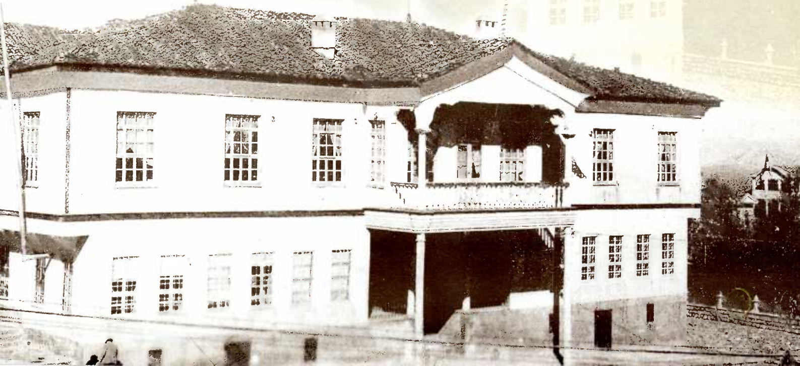
Eski Hükümet Konağı (1930)
